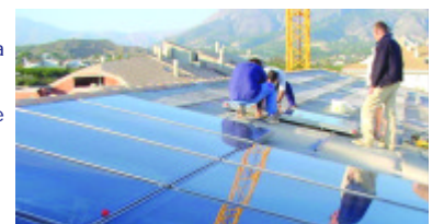
Bildet viser solpanel montert på tak (På Bærums Recidencia).
