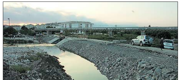
RIO ALGAR: Denne demningen har måtte forsterkes i etterkant av flommen.
