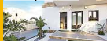
SA-2568 Nye eneboliger i rekke, med åpent kjøkken, høy standard med gulvvarme, integrert AC, hydromassage, 3 sov, 3 bad, 125m2
